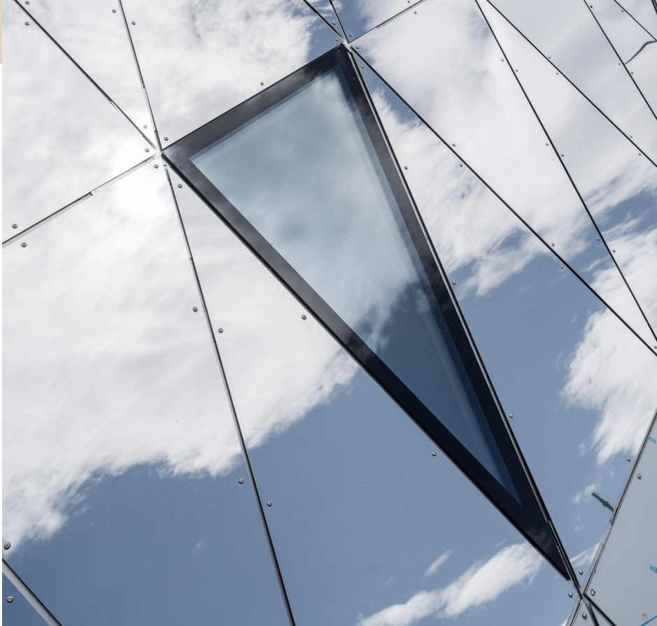
Detailansicht: Blechverkleidung mit integriertem Glaselement. Vue détaillée : revêtement de tôle avec élément vitré intégré.
